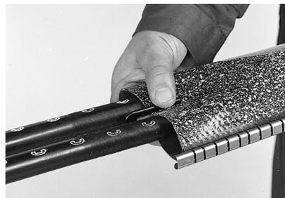
2.17 Klammer so setzen, dass die Öffnung der Schrumpfmanschette ungefähr im Verhältnis der Kabeldurchmesser aufgeteilt wird. Klammer bis zum Anschlag in die Manschette einführen. Nach der Klammermontage Mittigkeit der Schrumpfmanschette anhand der Markierung überprüfen!
