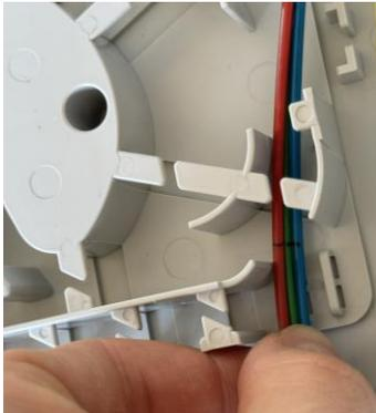
Die Bündeladern kurz hinter der Fixierungsstelle am Eingang des Faserüberlängenspeichers markieren und mit dem passenden Werkzeug absetzen.
