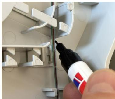
Die Bündelader kurz hinter der Fixierungsstelle am Eingang des Faserüberlängenspeichers markieren und mit dem passenden Werkzeug absetzen.
