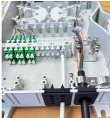
Die Dichtung SEAL-8X4(D) gemäß Punkt 7.1.1 vorbereiten und von oben in den gewünschten Port einsetzen.
