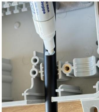
Das Kabel ca. 5 mm hinter dem vorgesehenen Befestigungsbereich markieren und anschließend absetzen.
