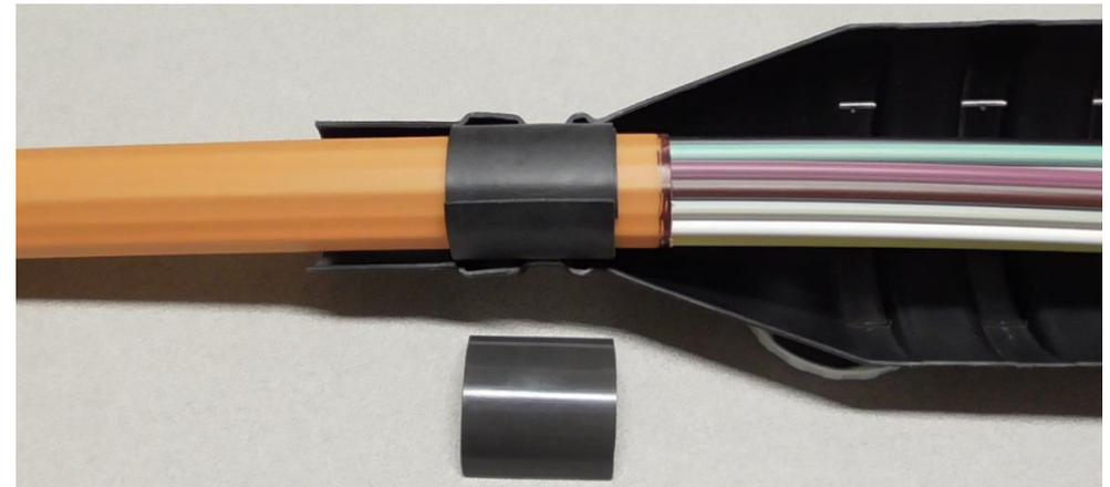
1.7 Auf den Gummistreifen wird anschließend der Sicherungsbogen aufgelegt.
