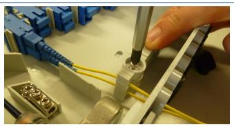
Anschliessend die Kabel durch die geöffneten Eingänge der Gummitüllen einlegen und die Gummitüllen wieder in die Gehäuseöffnung installieren.
