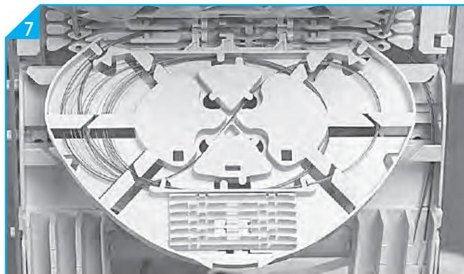
14.6 Die Faserführung ist für die vier Kassettentypen (SC, SE, SLE, Ribbon) gleich. Die Faser- und Bündeladernummerung kann mit einem Permanent Marker in den im oberen Bild gekennzeichneten Bereichen erfolgen.
